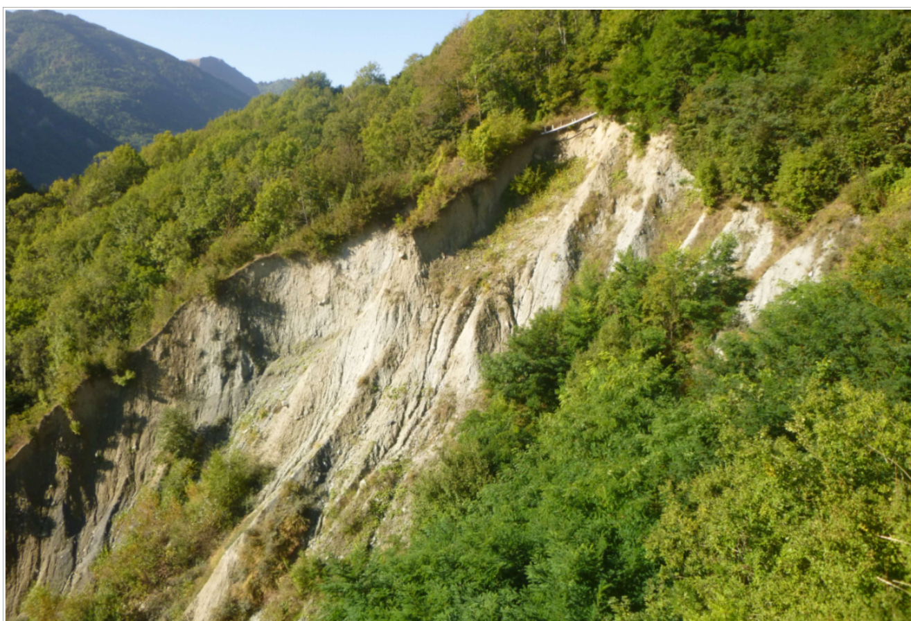
Vue de la niche d'arrachement côté Sud du ravin du Crêt Blanc, depuis le côté Nord. A la cime, le tuyau PVC de drainage suspendu (hors service). Alpes-Géo-Conseil sept.2024
