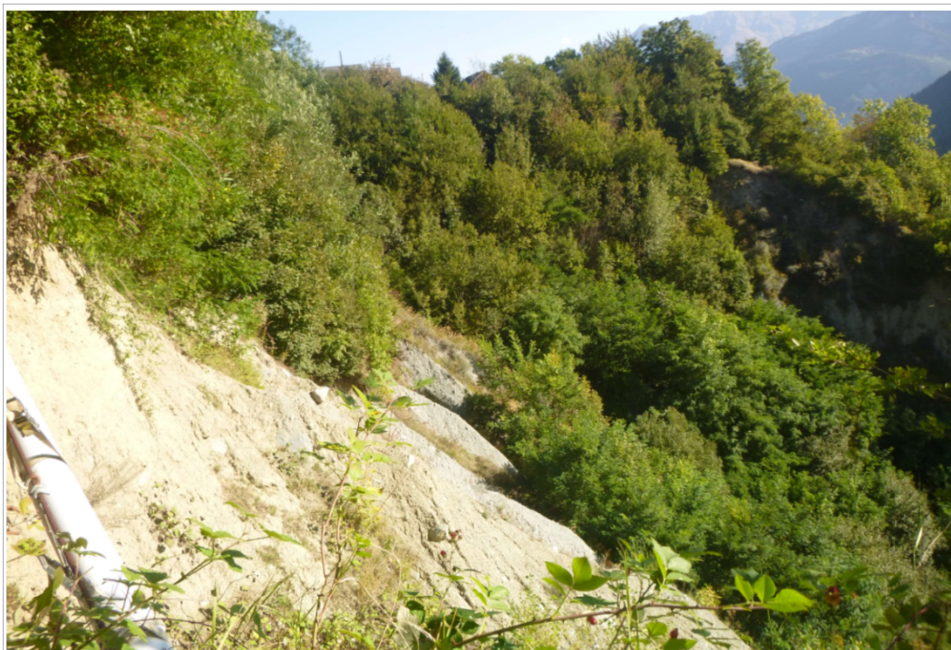
Vue de la niche d'arrachement du ravin du Crêt Blanc depuis le côté Sud, au niveau du tuyau PVC de drainage suspendu (hors service). Alpes-Géo-Conseil sept.2024
