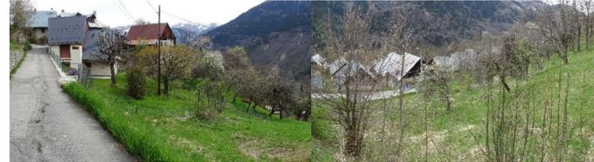
**Chef-lieu** – implantation perpendiculaire aux courbes de niveaux, bardage bois verticaux sous toits à deux pans constitués de taule ou de zinc bac acier. **Le Bessay** - toits de zinc/ bac acier et taules avec une implantation perpendiculaire aux courbes de niveaux parfaitement intégrée dans la pente.
